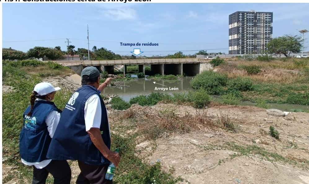
Figura 1.31. Construcciones cerca de Arroyo León
